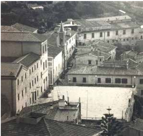
Figura 43. Portoferraio. Magazzino dei viveri di François-Louis-Joseph Garin, Veduta del piazzale sulla copertura
