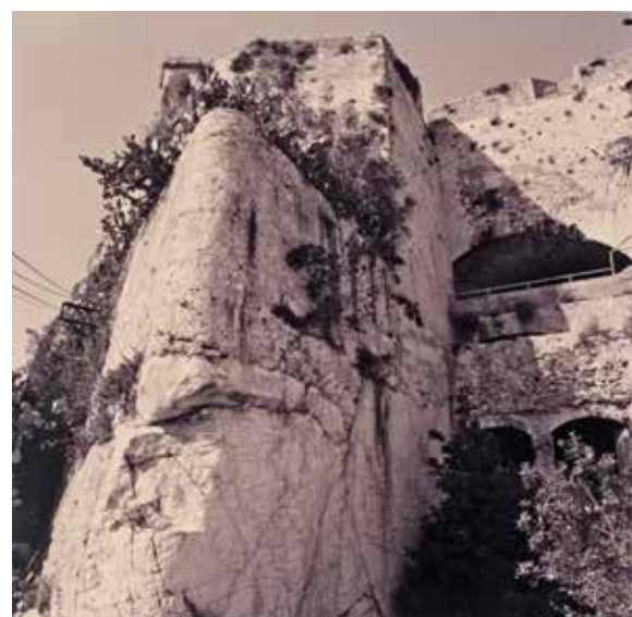
Figura 15. Portoferraio. Fronte di terra. Fianco sinistro ritirato tagliato nella roccia del baluardo Buontalenti
